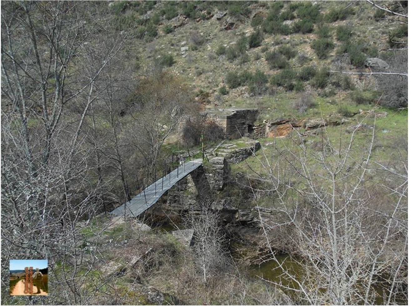
Puente sobre el Bornova
